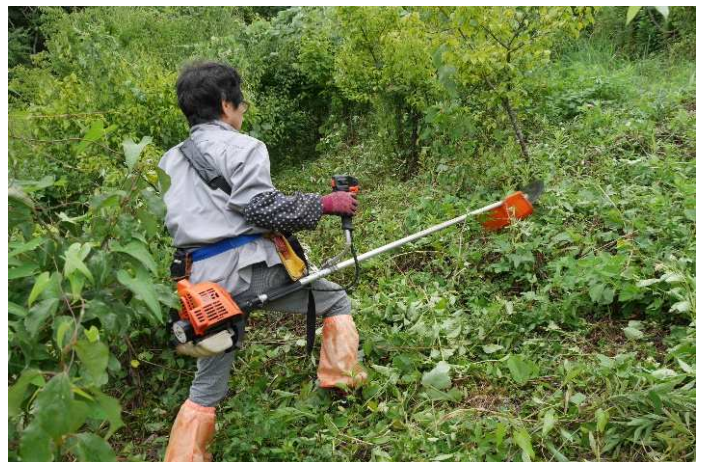
▲急傾斜地でも、作業の手は止まらない
